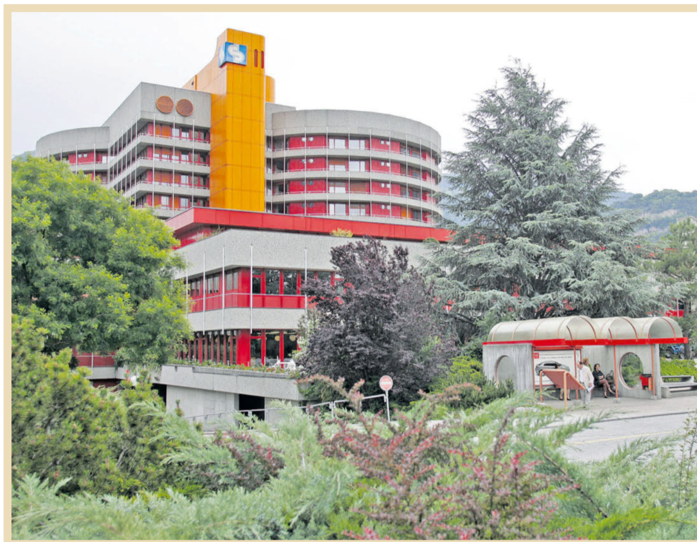
In Champsec, ausserhalb der Stadt Sitten, entsteht ein neues und modernes Spital, das Ende 1979 in Betrieb geht.
