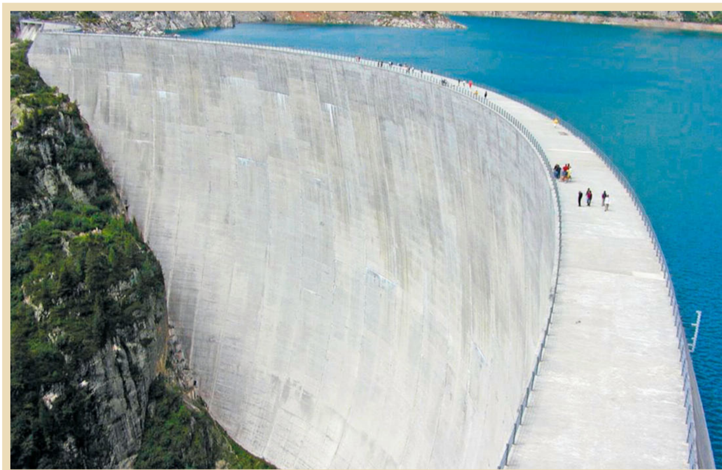
In Emosson wuchtet sich eine 180 Meter hohe Staumauer in die Höhe, sie nutzt die Wasser von Barberine.
