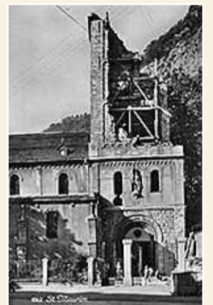
Steinschlag beschädigt Turm und Kirche der Abtei von Saint-Maurice. zvg
