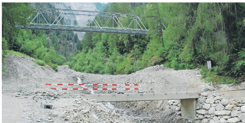
Die Brücke über den Rufibach kann wieder befahren werden.
