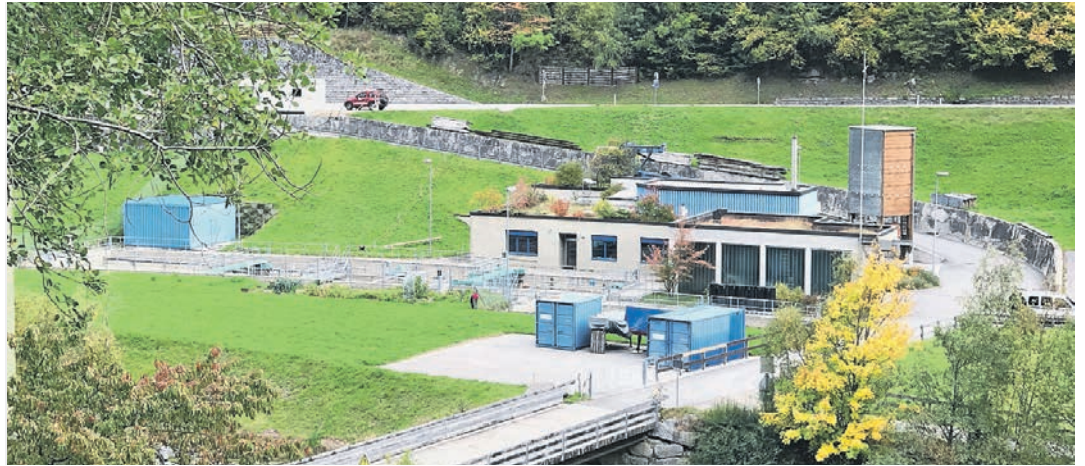
Die ARA in St. Niklaus ist derzeit nur beschränkt in Betrieb.
