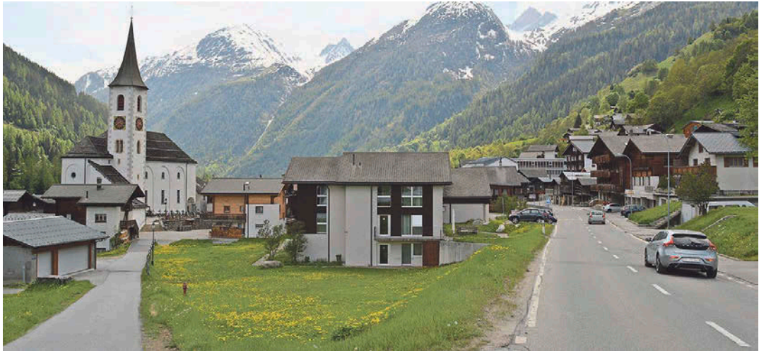
Die Strasse durch das Dorf Kippel wird diesen Sommer saniert.
