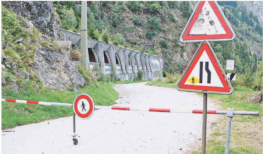
Die Fahrt über die alte Talstrasse ist gesperrt. Links im Bild der Mittaltunnel.
