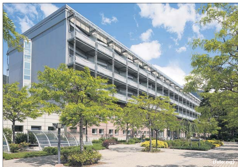
Leere Räume im Spital Siders könnten an Ärzte aus der Region vermietet werden.
