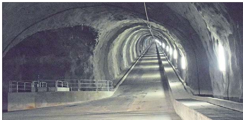
Der unterirdische Bahnhof Ferden – hier fahren Postautos nur im Notfall mit Reisenden nach Goppenstein.
