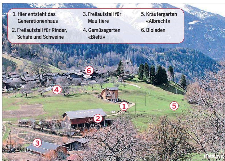
Mit dem Bau des Generationenhauses in Ernen soll Ende Sommer begonnen werden.
