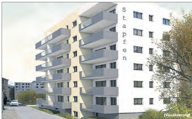
Das Mehrfamilienhaus Stapfen in Naters – hier sollen 19 Wohneinheiten entstehen.
