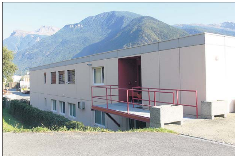
Zäune und Kameras: Nach diversen Vorfällen wurden die Massnahmen verschärft.
