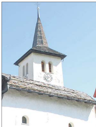
Der Unteremser Glockenturm wird saniert.
