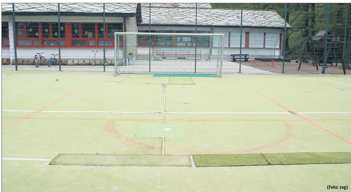
Sanierungsbedürftig: Der Weg zu diesem Tor wird in Zukunft weniger holprig sein.
