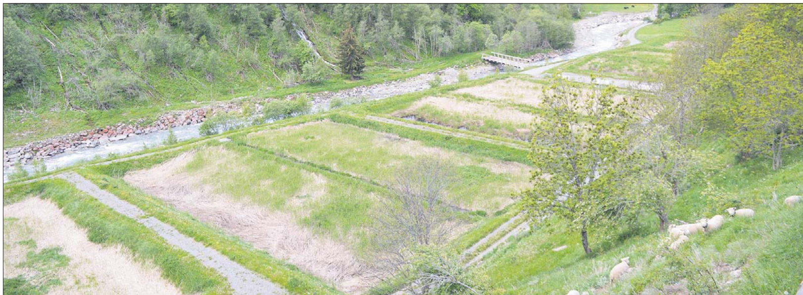
Mangelhafte Funktion: Die Wurzelraumkläranlage in Wiler sorgt weiterhin für Zündstoff. Schlecht gereinigtes Abwasser fliesst in die angrenzende Lonza.
